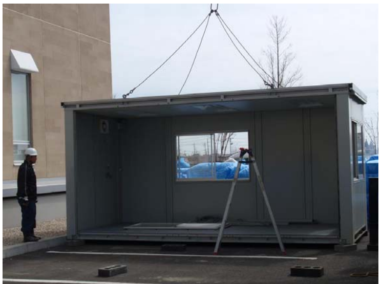
クレーンで設置場所に降ろされるプレハブユニット
