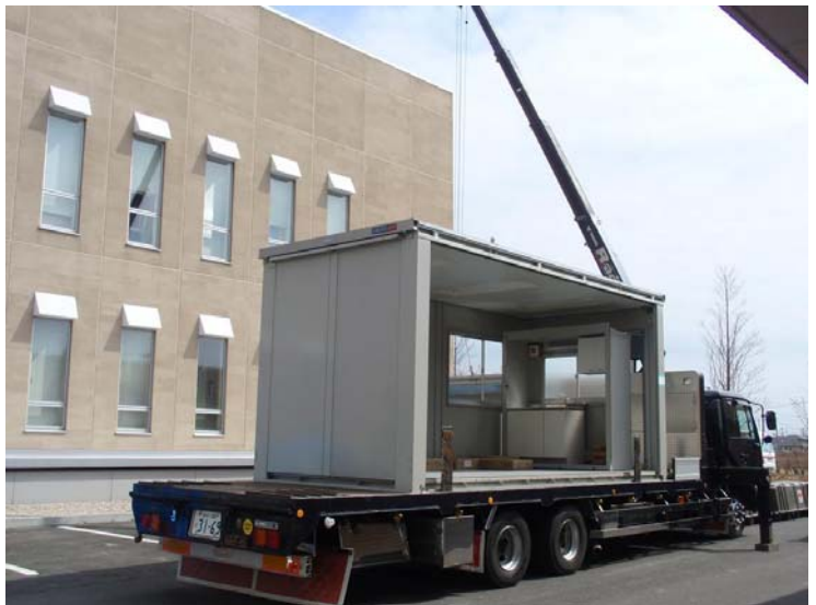
プレハブを1棟ずつトラックで搬入
